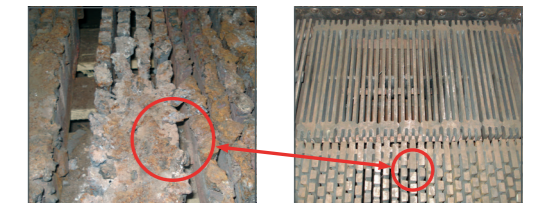
Roststäbe: Abbrand entsteht durch grosse Hitze und schlechte Qualität der Kohle.
